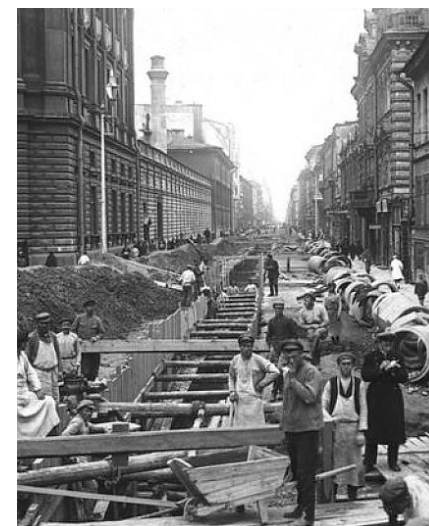
Прокладка водопровода на питерских улицах.
